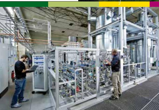
Die Power-to-Gas-Anlage am ZSW wandelt Ökostrom in Qualitätsgas mit 99 Prozent Methan um.
