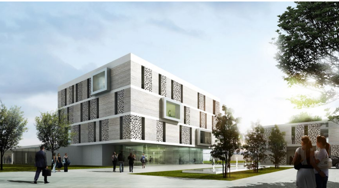
In Taschkent, der Hauptstadt der zentralasiatischen Republik Usbekistan, entsteht im Auftrag des Auswärtigen Amtes bis 2018 ein Kanzleigebäude für die Deutsche Botschaft.
