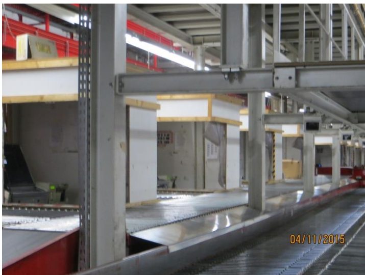
Bild: Eingehauste Scannerarbeitsplätze mit beheizten Fussmatten und Heizradiatoren
