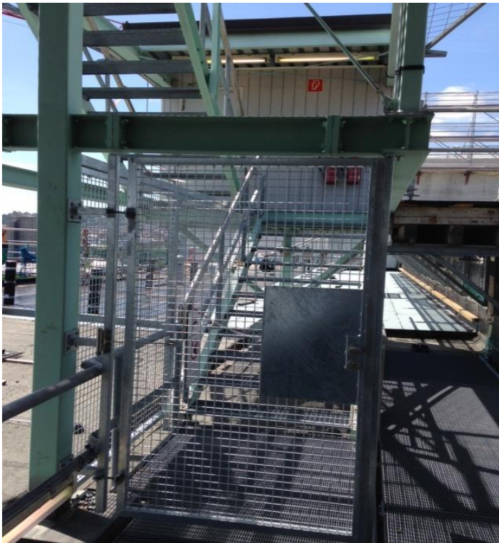
Bild: Beidseitiger Seitenschutz
