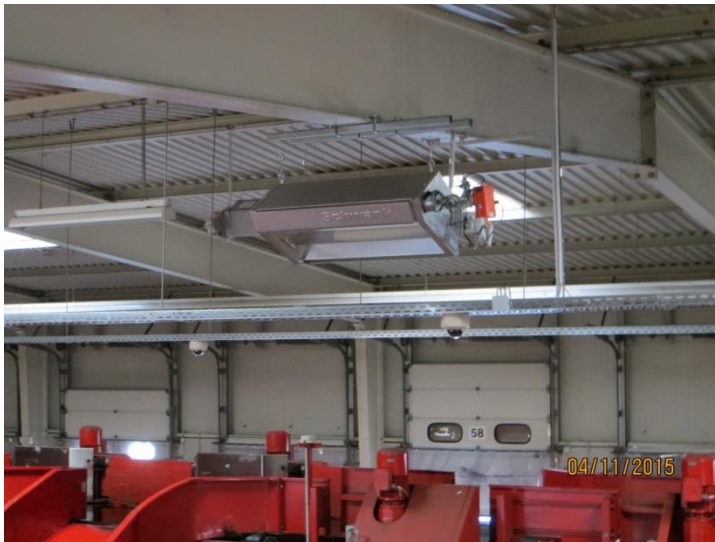
Bild: Eingebaute Strahlungsheizungen an den LKW Be- und Entladetoren
