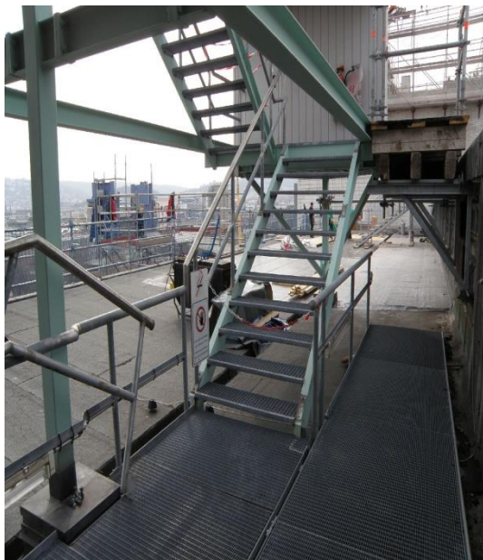
Bild: Mit Kette gesicherter Zugang.
