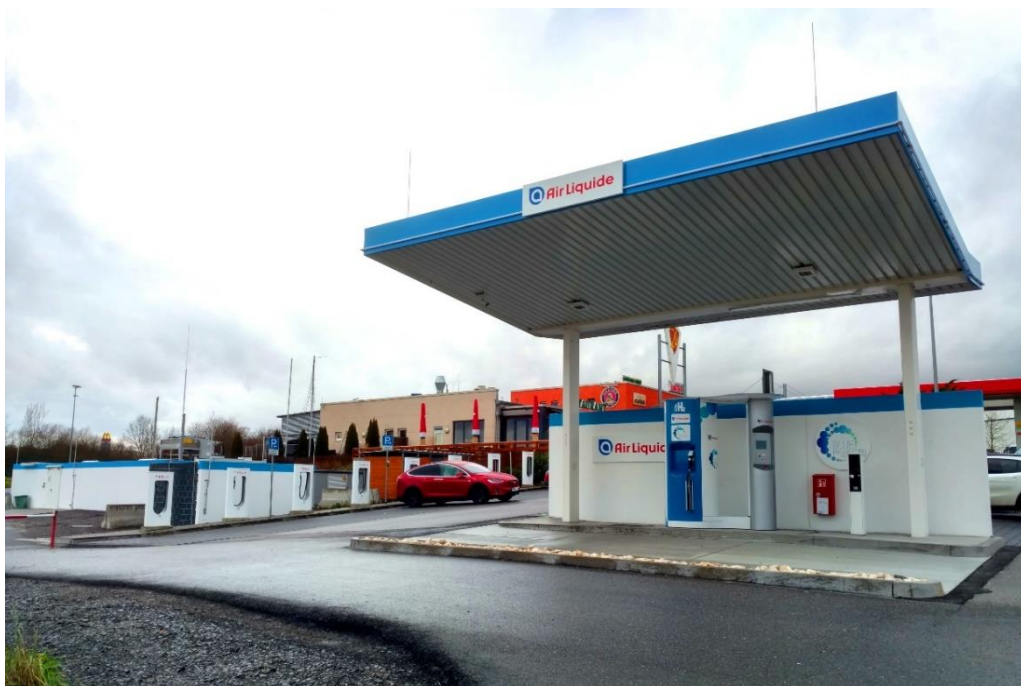
Bild 1: Die erste Wasserstofftankstelle im Landkreis Heilbronn Beitrag des Landratsamtes Heilbronn
