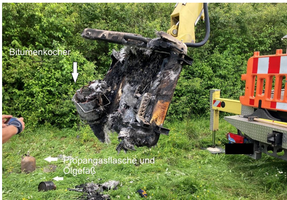
Bild: Absturzunfall Hubsteiger
