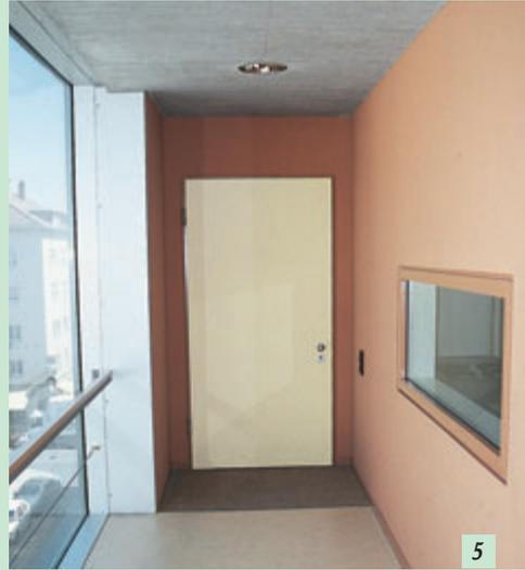
*5. Kontrastreiche Gestaltung der schwellenlos zugängigen Wohnungseingangstüren mit sicher und leicht greifbaren Bedienelementen in optimaler Greifhöhe*
