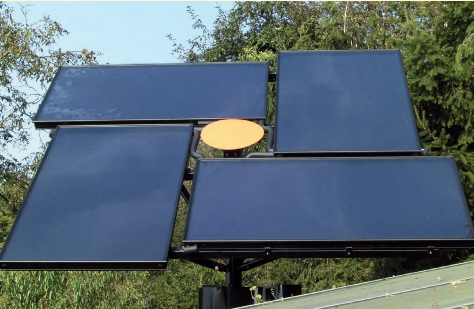
Eintragungsoptimierte, nachgeführte thermische Solaranlage „Solarblume“/„PowerFlower“ am Standort Bodensee.
