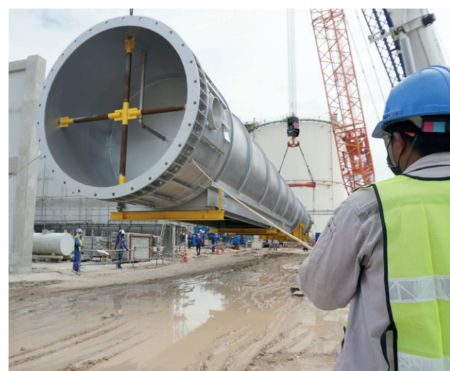
Einsatz der Tracker beim Transport einer Gasturbine
